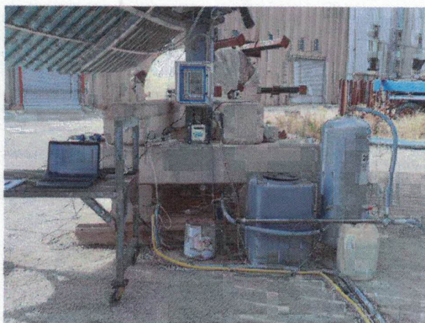
Foto del circuito termo-idraulico annesso al sistema in prova
